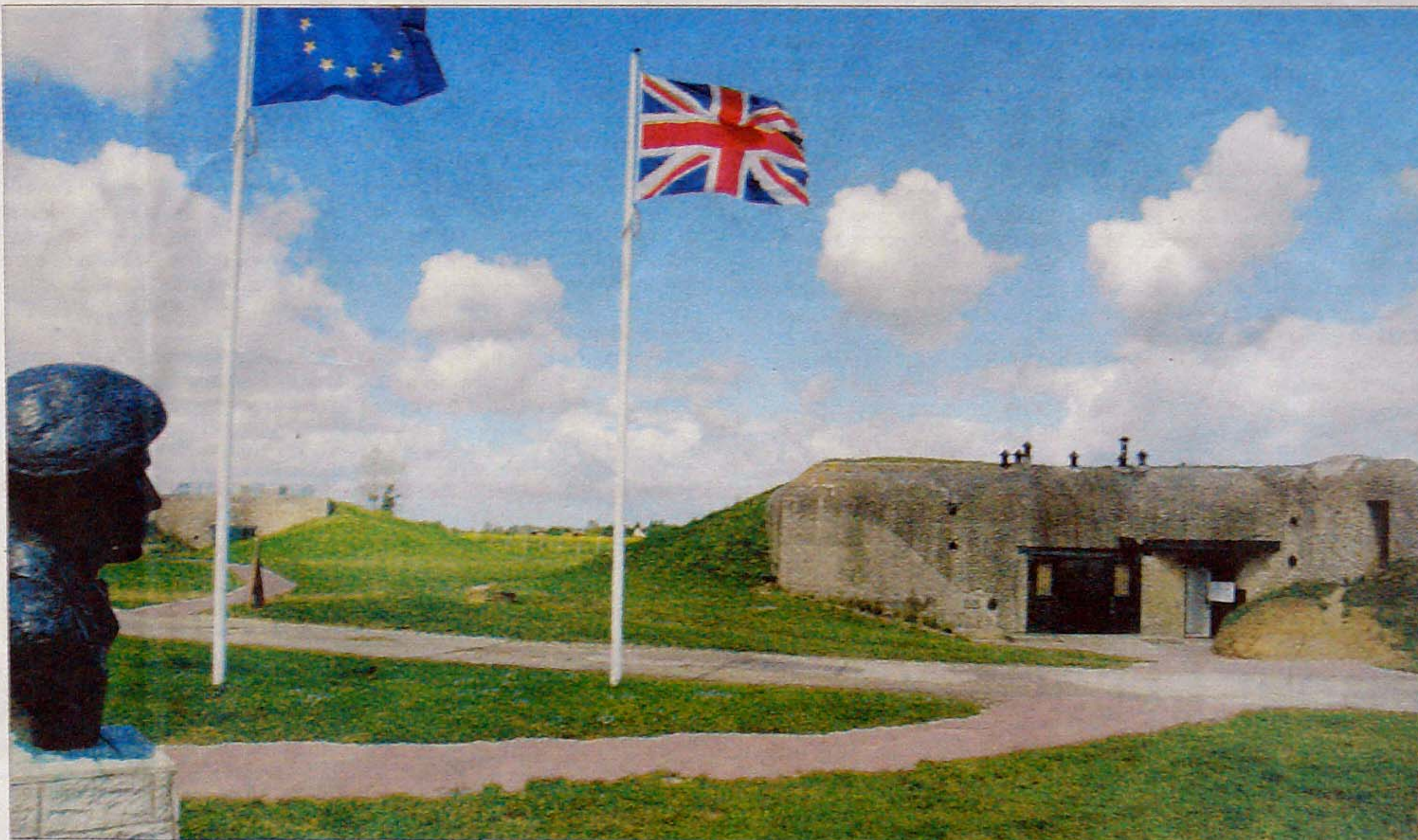
Au fil de la guerre, l'armée allemande a construit ses casemates pour se protéger des bombardements aériens.
